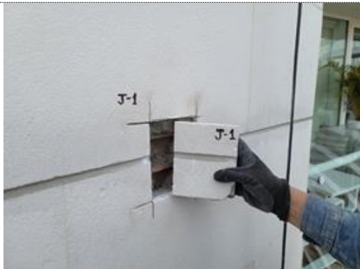
Imagen 61. Corte en junta flexible. J - 1
