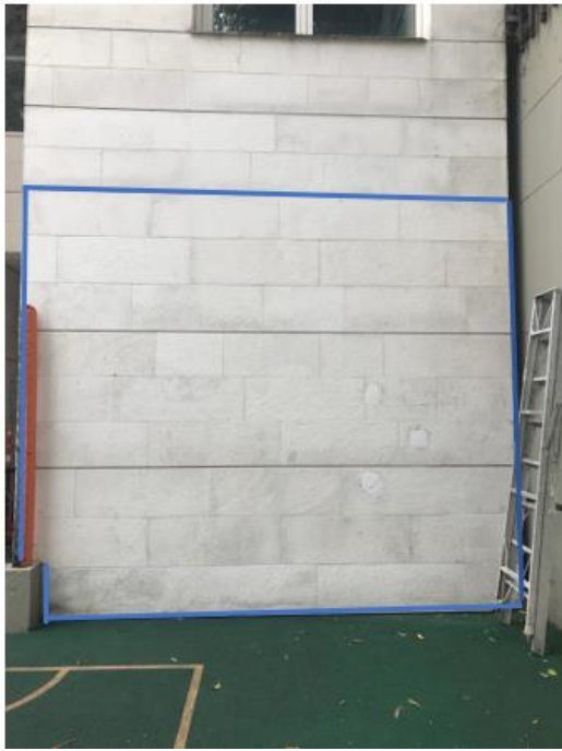
Imagen 67. Muro de fachada sur.
