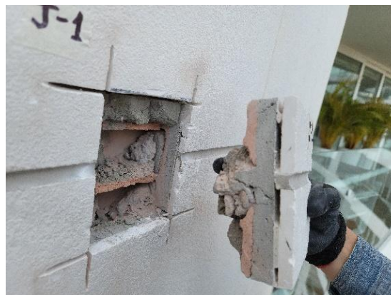
Imagen 74. Vista de uno de los apiques hechos para verificar el corte del sustrato en la junta.
