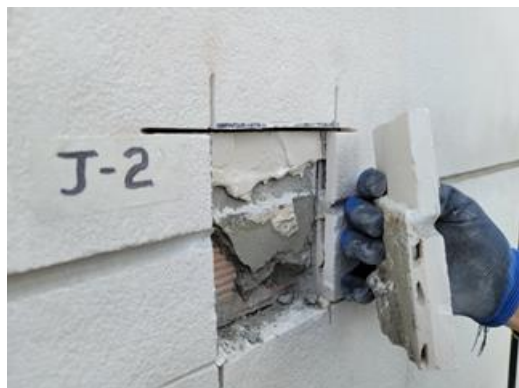
Imagen 64. Detalle corte junta flexible. J - 2
