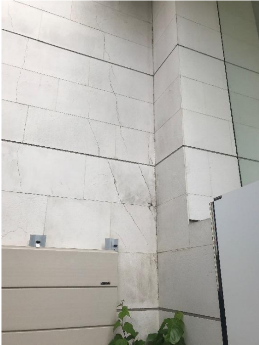
Imagen 20. fisuración.
