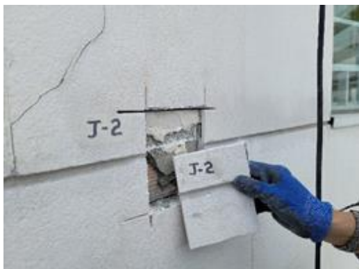
Imagen 63. Corte en junta flexible. J - 2
