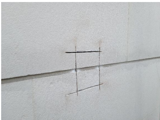
Imagen 74. Vista de uno de los apiques hechos para verificar el corte del sustrato en la junta.
