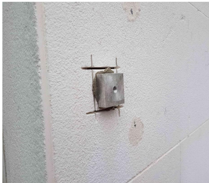
Imagen 71. Detalle del corte y la pega de la platina con epóxico
