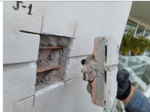
Imagen 62. Detalle corte junta flexible. J - 1
